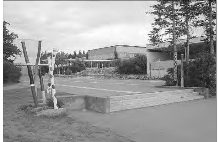
Zum Tag der offenen Tür konnte der neu gestaltete Eingangsbereich des Schulhofes präsentiert werden.
